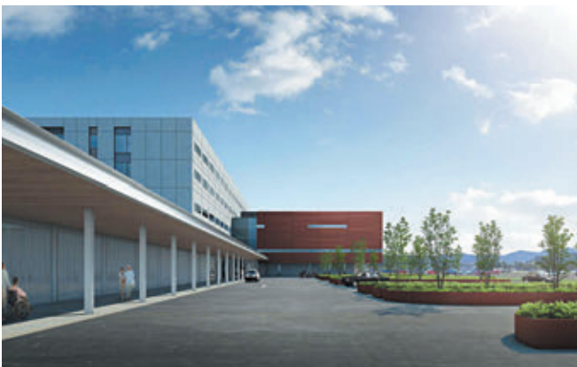
正面玄関(西側より)
